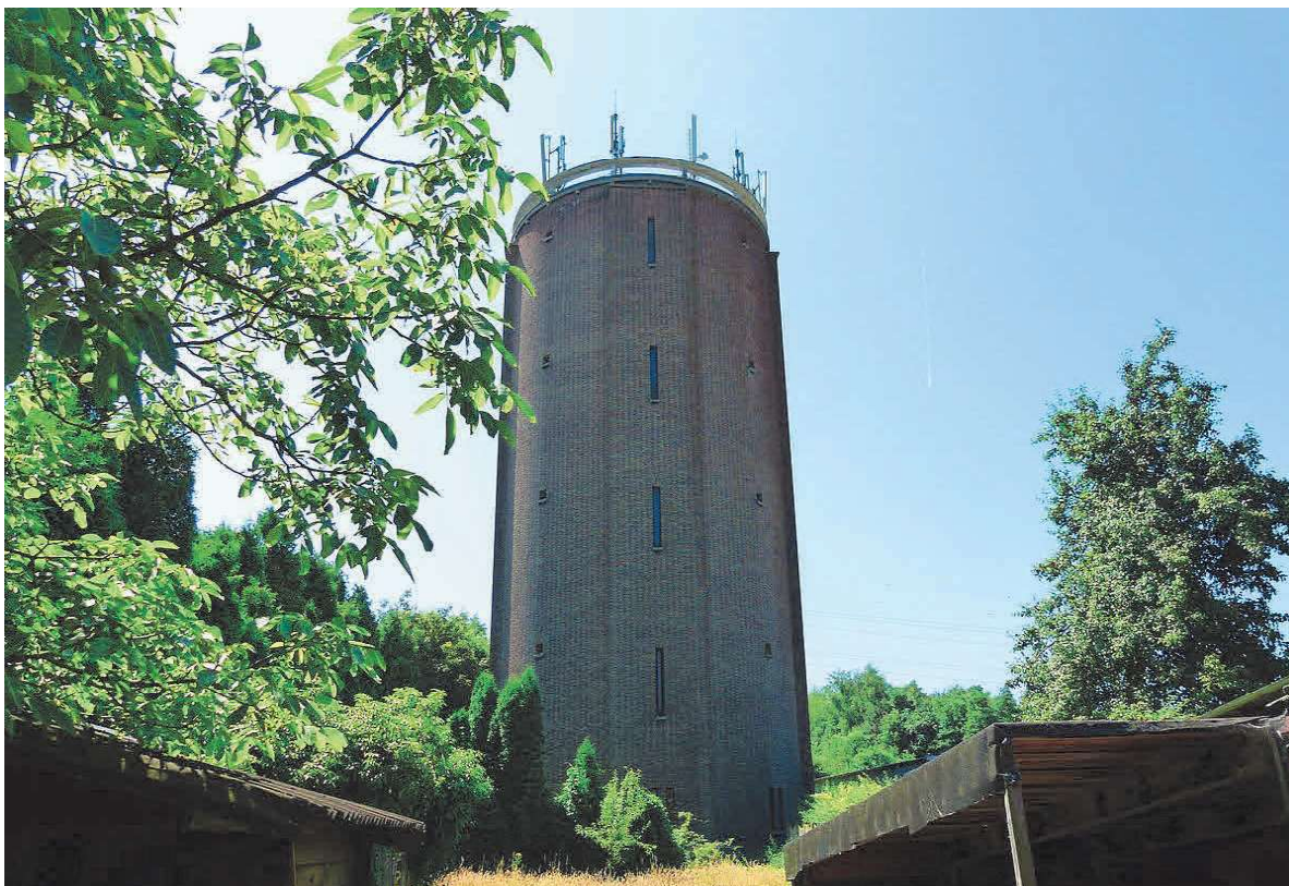
Watertoren aan de Pierstraat (nabij het einde van de Eikenstraat)
